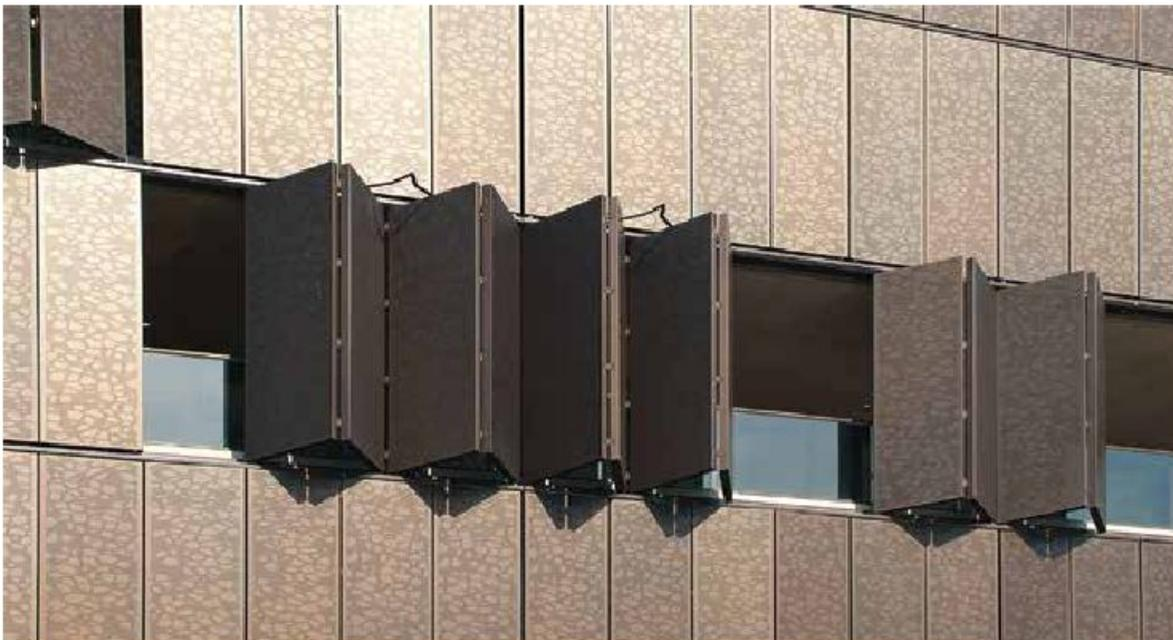
سایه بان آکاردئونی هنگام باز شدن، فضای بسیار کمی اشغال می کند. این سیستم توسط لولاهای باکیفیتی کار می کند که در هنگام باز یا بسته بودن پانل ها، قابلیت قفل شدن دارند، به همراه یک دستگیره ی ویژه و سیستم نگهدارنده ی مغناطیسی که کیفیت کارکرد آن را افزایش می دهد. پانل های سایه بان آکاردئونی مکررا قابل باز و بسته شدن هستند. دو مدل از این سیستم وجود دارد: مدل قوطی و مدل طراحی اختصاصی که به دلخواه طراحی قابل استفاده هستند.
